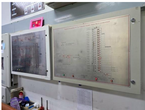
รูปที่ 2-35 ตู้ควบคุมระบบป้องกันอัคคีภัย และเบรคเกอร์ฉุกเฉิน
